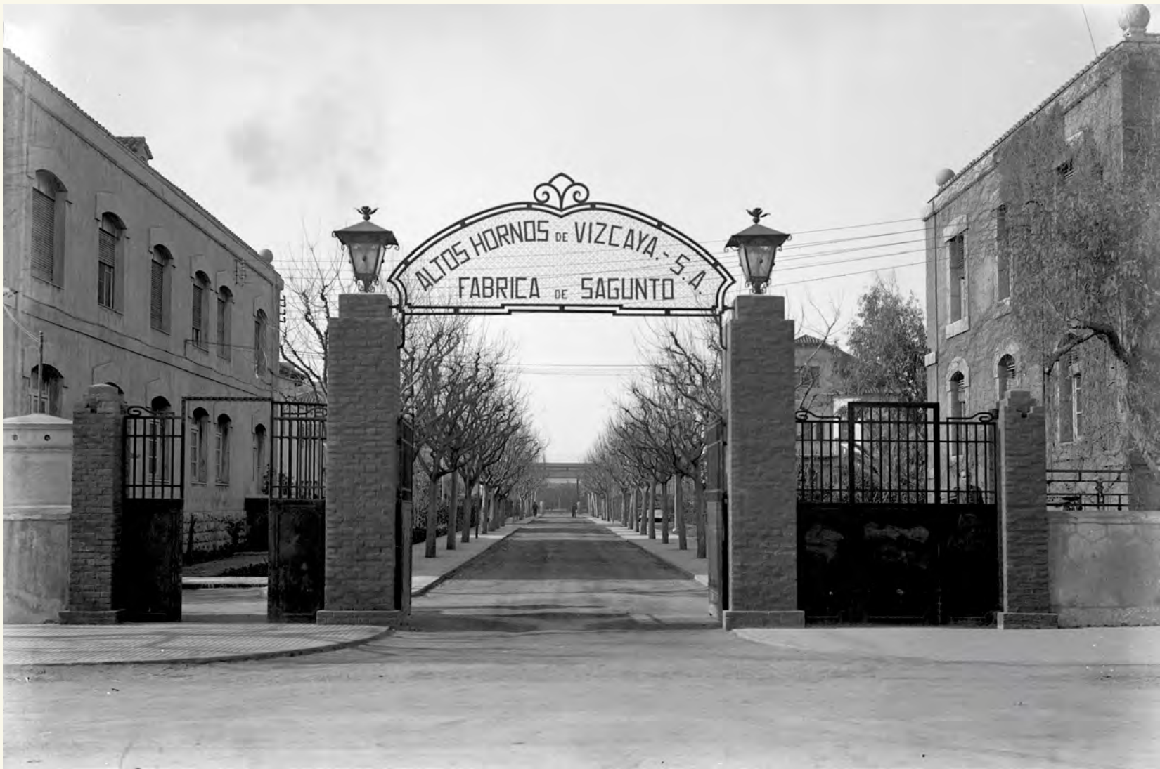
Entrada a la zona residencial "La Gerencia", la ciudad-jardín para los altos cargos y directivos de la siderurgica. de Fotógrafo: León San Bernardo Soler (1896-1975)
